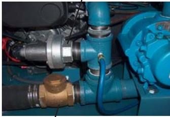
Soupape de retenue d'air
