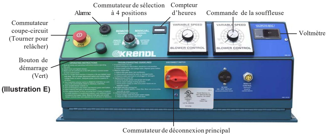
6. Pour le fonctionnement en **mode à distance**, le commutateur de sélection à 4 position est mis en position **Remote/distant**. (Voir Illustration E)
